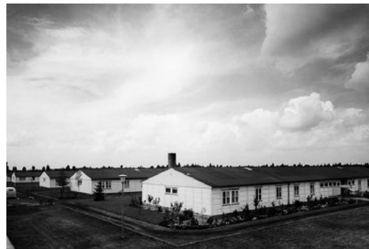
Neue Unterkünfte in Stukenbrock NRW 1960 BN Archiv Plücklemann (Foto: Lohöfener)
